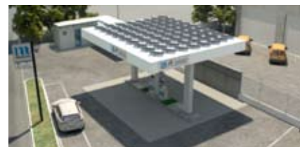
Impianto a metano, adiacente alla sede Amsc, alimentato da pannelli fotovoltaici
